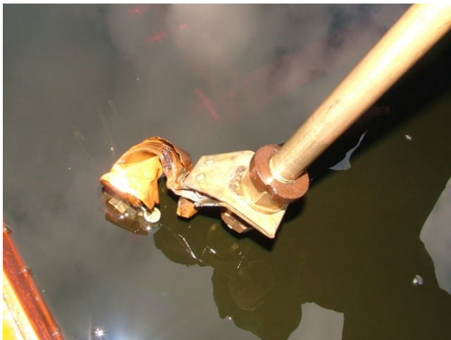
Slika 3 – Razlabavljen spoj savitljive veze i šipke 35 kV u fazi “C”
