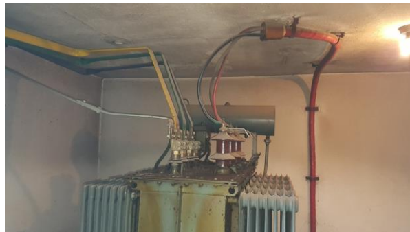
Слика 3 – Трансформаторска станица у сутерену стамбене зграде (10/0,4 kV, 1 × 630 kVA) [13]
