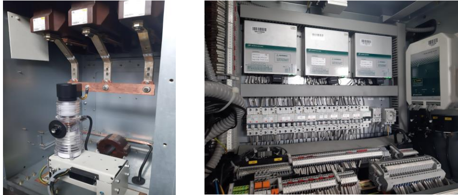
Slika 3 - Izgled kablovskog prostor ćelije ZP i NN odeljak posle ugradnje četvrtog pola
