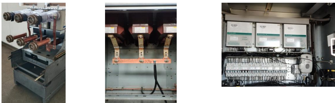
Slika 2 - Izgled kolica sa polovima ZP, kablovski prostor ćelije ZP i NN odeljak -pre ugradnje četvrtog pola
