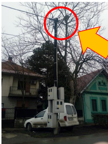
Slika 9 Pogrešno pozicioniranje priključaka kupaca na stablu stuba sa nepropisno grupisanim IMO, u Boljevcima
