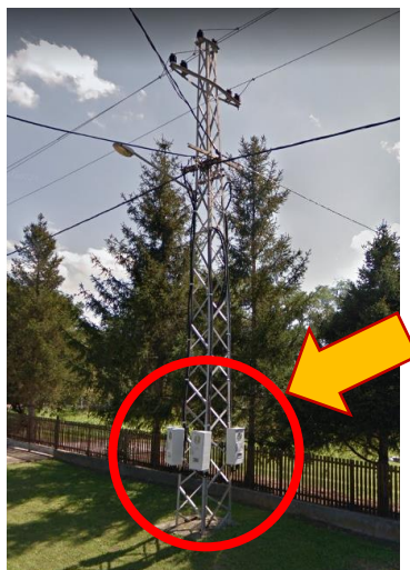
Slika 4 Grupisanje i montaža IMO pod uglom u odnosu na vertikalu, na rešetkastom stubu SN+NN mreže u selu Ratari
