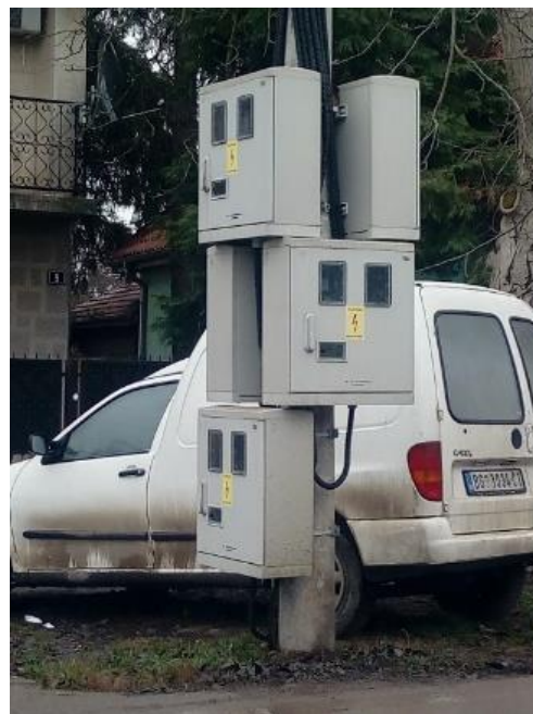
Slika 8 Grupisanje IMO na stablima betonskih stubova nadzemne mreže u Boljevcima
