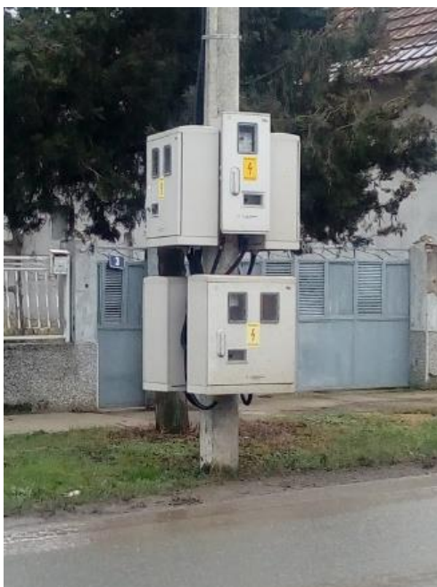
Slika 8 Grupisanje IMO na stablima betonskih stubova nadzemne mreže u Boljevcima
