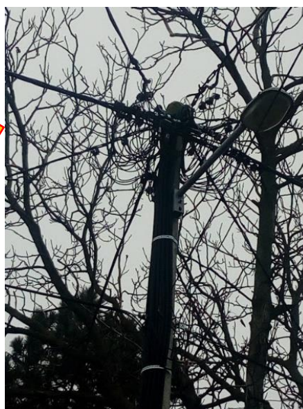
Slika 9 Pogrešno pozicioniranje priključaka kupaca na stablu stuba sa nepropisno grupisanim IMO, u Boljevcima
